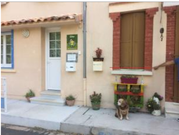
Vue de la façade. L'eau est montée jusqu'au-dessus de l'allège de la fenêtre (trait rouge)
