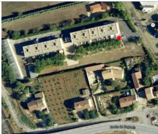
Vue du site
