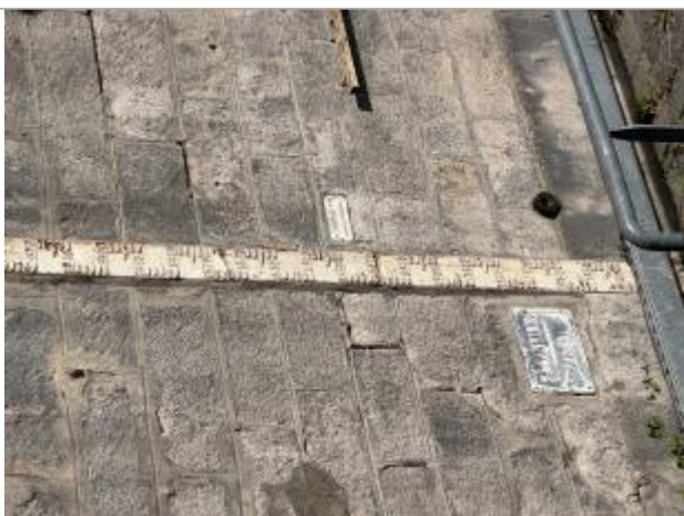
Photo des repères
