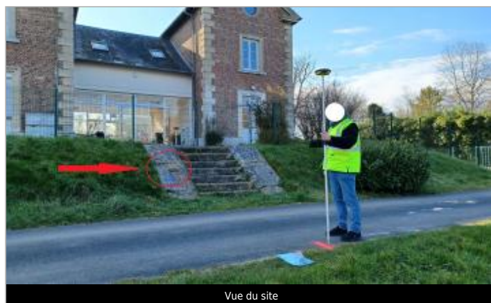
Vue du site
