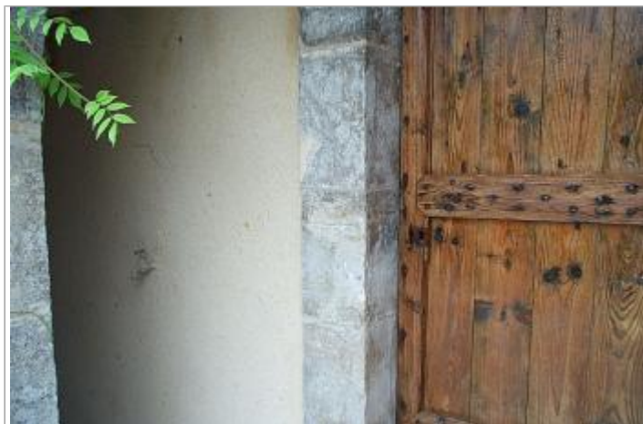
Vue du site
