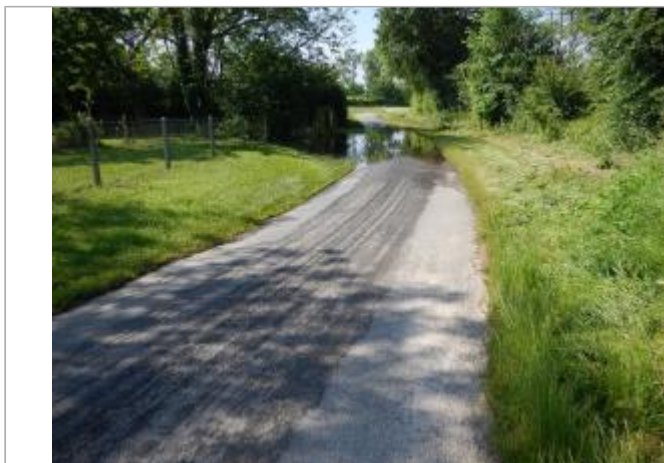
Site pendant la crue
