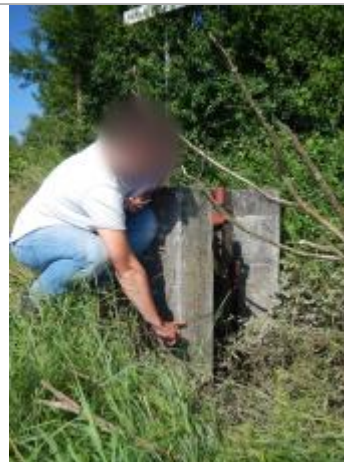
Site et repère de la crue de juin 2016
