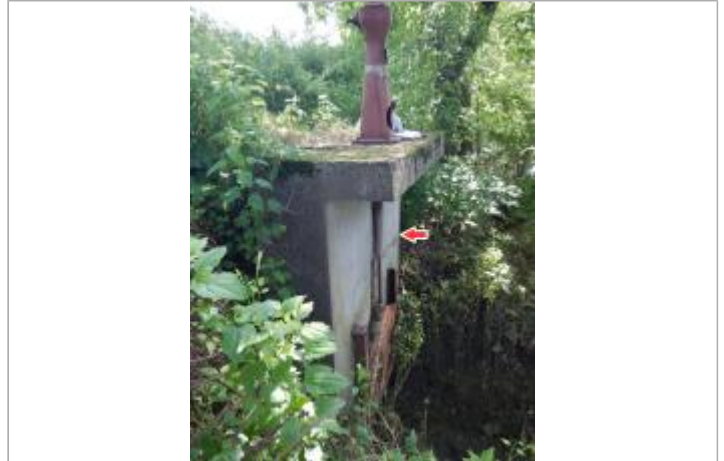
Site en 2016 avant démolition, et repère de la crue de juin 2016
