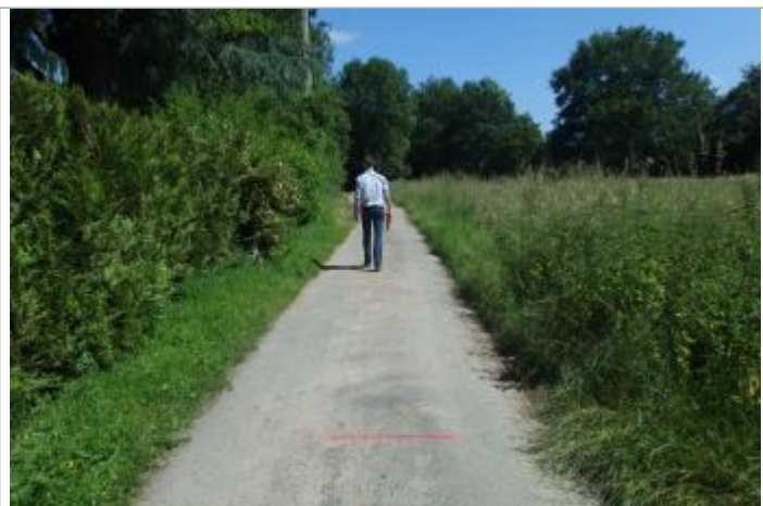
Repère : marque de peinture sur la chaussée
