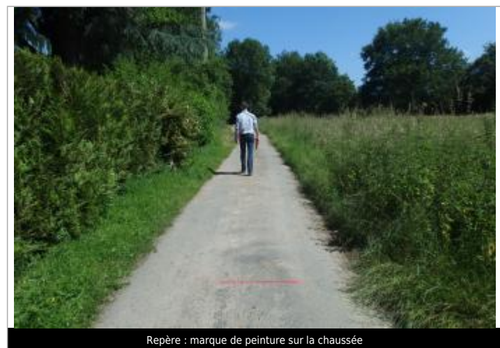
Repère : marque de peinture sur la chaussée
