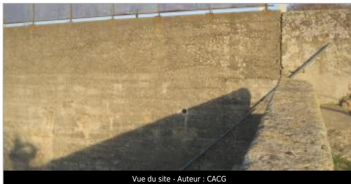
Vue du site - Auteur : CACG
