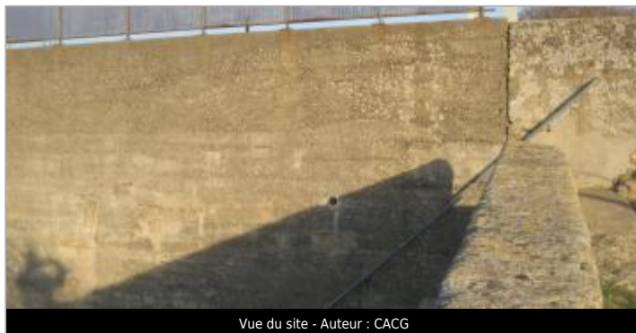
Vue du site - Auteur : CACG
