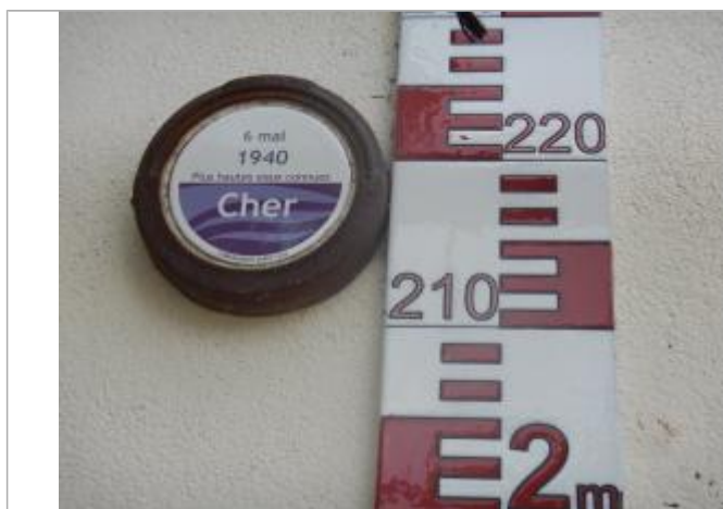
Repère de la crue du 6 mai 1940
