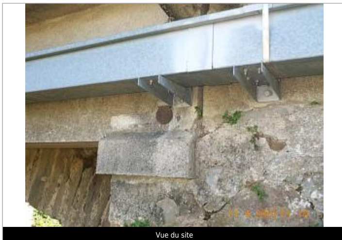
Vue du site
