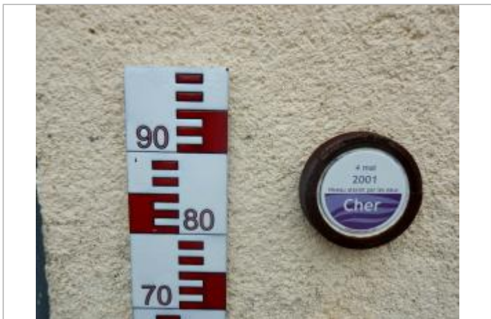
Repère de la crue du 4 mai 2001
