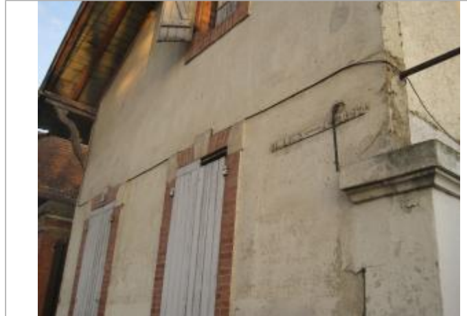
repère de crue 1897 façade Avenue Hoche n°3 contre-allée gauche
