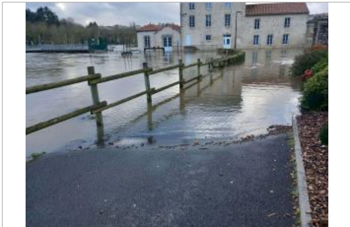
Crue février 2026 - Saint Laurent (rue de chaussac) - photo 1
