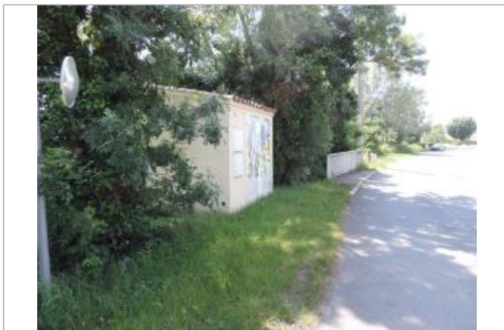
Vue de situation - Auteur : EPTB_Charente
