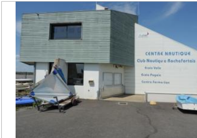
Vue de situation - Auteur : EPTB_Charente
