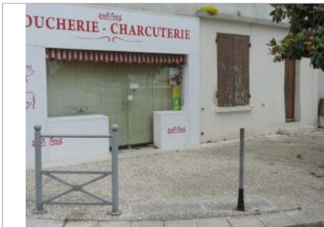
Vue de situation - Auteur : EPTB_Charente
