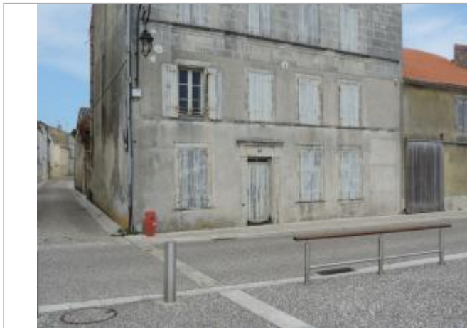
Vue de situation - Auteur : EPTB_Charente
