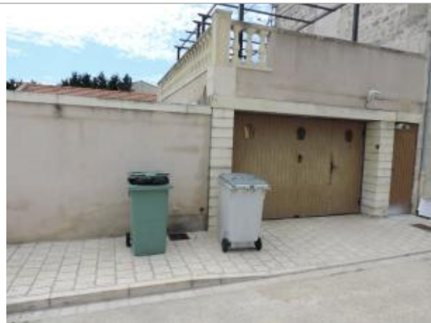
Vue de situation - Auteur : EPTB_Charente
