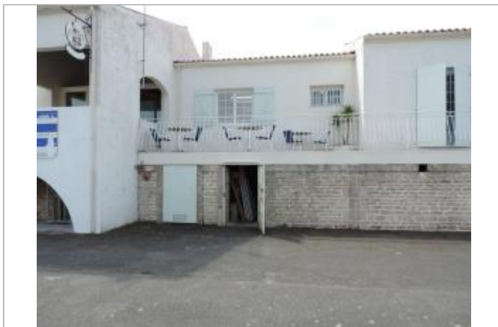
Vue de situation - Auteur : EPTB_Charente
