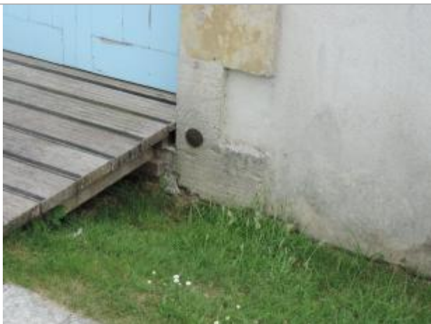
Vue détaillée - Auteurs : EPTB_Charente
