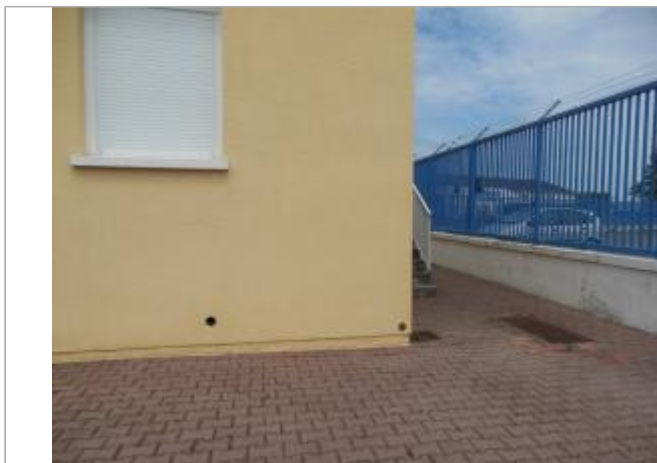
Vue de situation - Auteur : EPTB_Charente
