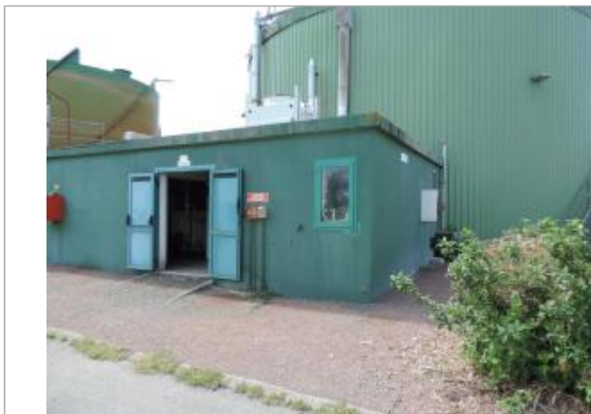
Vue de situation - Auteur : EPTB_Charente
