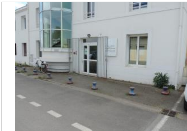
Vue de situation - Auteur : EPTB_Charente
