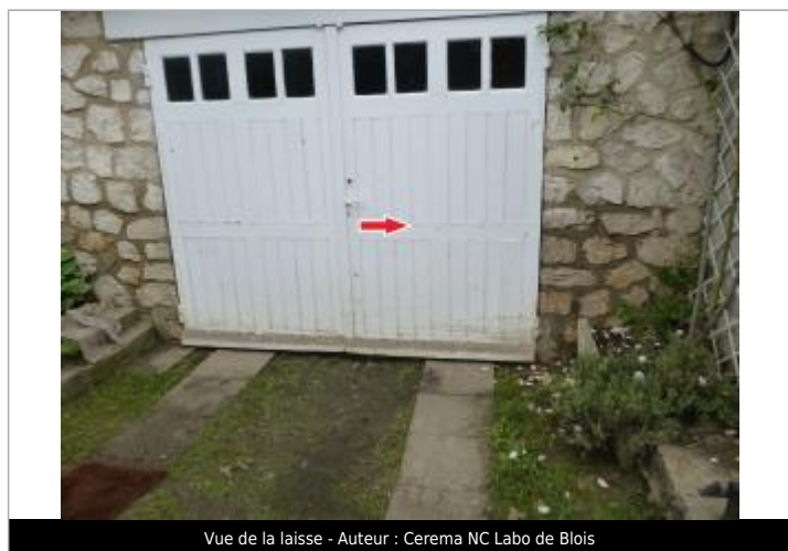
Vue de la laisse - Auteur : Cerema NC Labo de Blois
