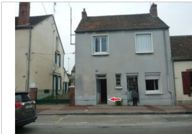
Vue du site - Auteur : Cerema NC Labo de Blois
