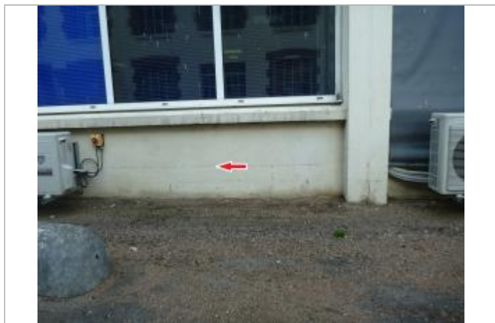
Vue de la laisse - Auteur : Cerema NC Labo de Blois
