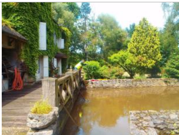
Vue de la laisse - Auteur : Cerema NC Labo de Blois
