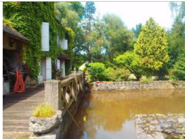
Vue du site - Auteur : Cerema NC Labo de Blois
