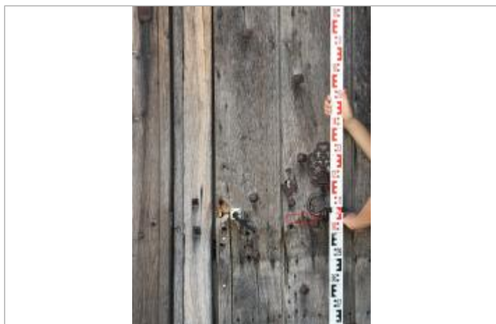
Vue de la laisse - Auteur : SPC SMYL
