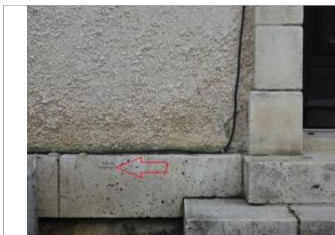
Vue de la laisse - Auteur : SPC SMYL
