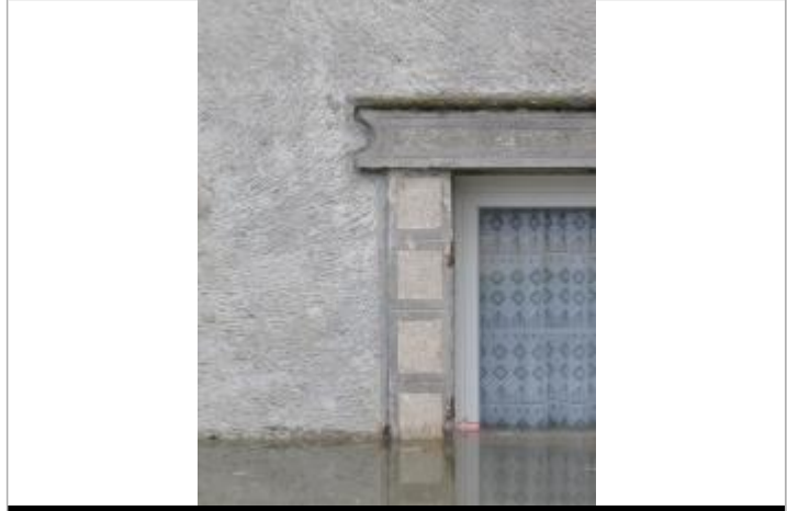
Vue de la laisse - Auteur : SPC SMYL
