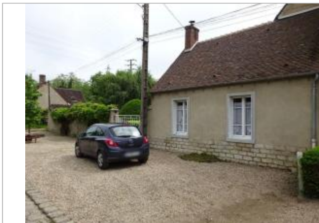
Vue du site - Auteur : SPC SMYL
