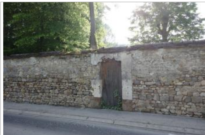
Vue du site - Auteur : SPC SMYL
