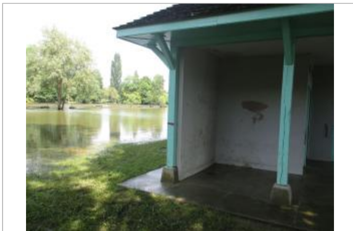
Vue du site - Auteur : SPC SMYL
