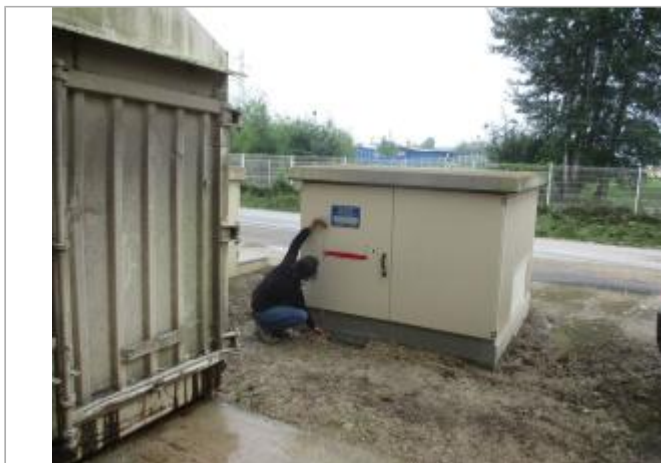
Vue du site - Auteur : SPC SMYL
