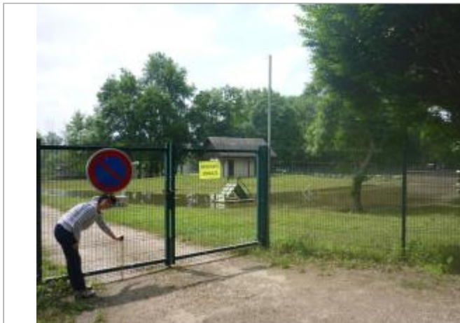
Vue du site - Auteur : SPC SMYL
