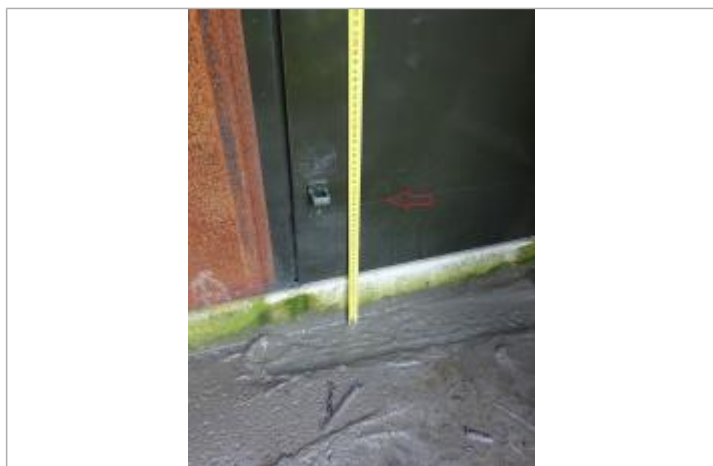
Vue de la laisse - Auteur : SPC SMYL
