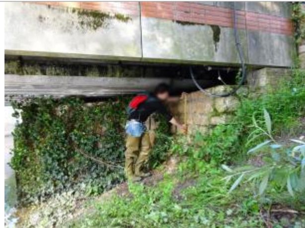
Vue du site - Auteur : SPC SMYL
