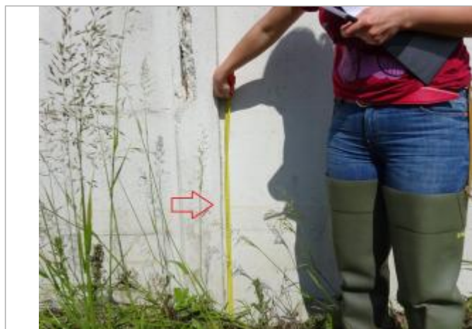
Vue de la laisse - Auteur : SPC SMYL
