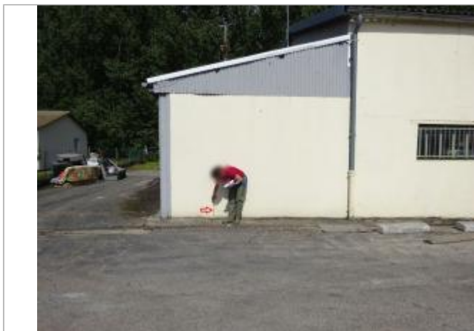
Vue du site - Auteur : SPC SMYL
