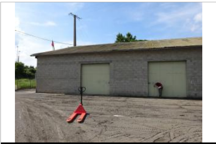
Vue du site - Auteur : SPC SMYL
