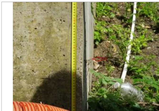
Vue de la laisse - Auteur : SPC SMYL
