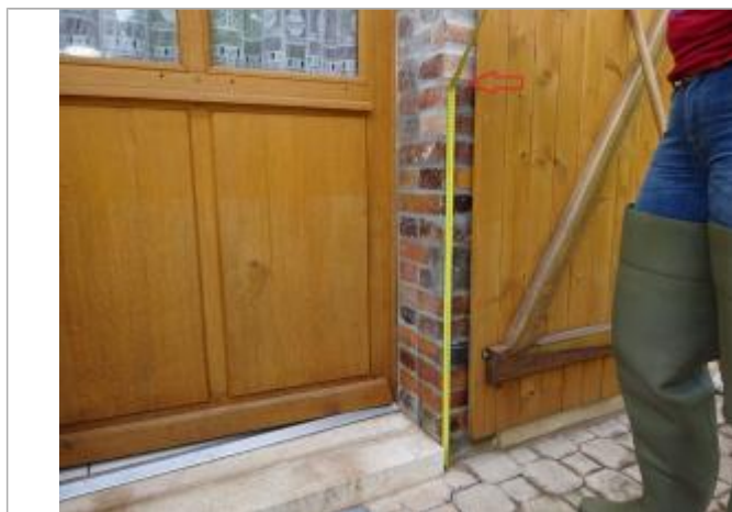
Vue de la laisse - Auteur : SPC SMYL
