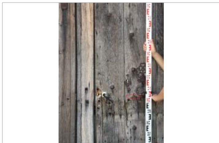
Vue de la laisse - Auteur : SPC SMYL
