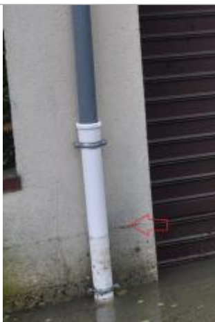
Vue de la laisse - Auteur : SPC SMYL
