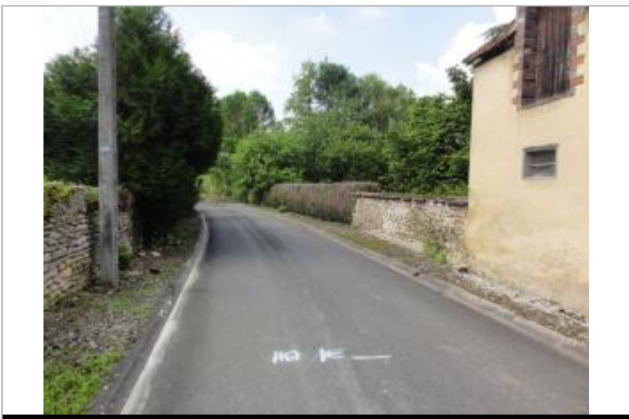
Vue du site - Auteur : SPC SMYL
