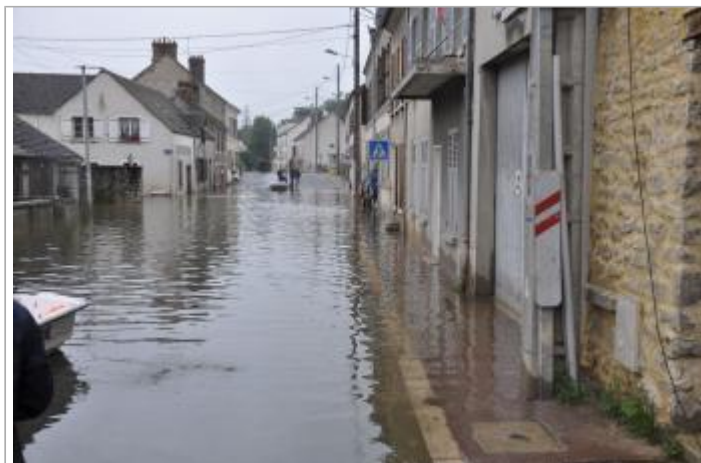
Vue du site - Auteur : SPC SMYL
