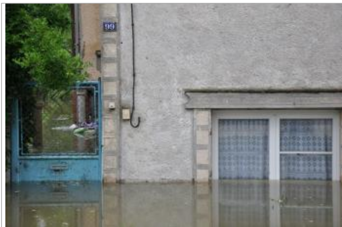
Vue du site - Auteur : SPC SMYL
